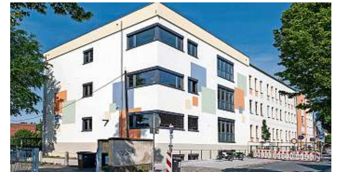
Die Heinrich-Zille-Oberschule in Radeburg wird derzeit erweitert und saniert. Für den Verbindungsbau gab es jetzt Nachtragsforderungen. Foto: Norbert Millauer
